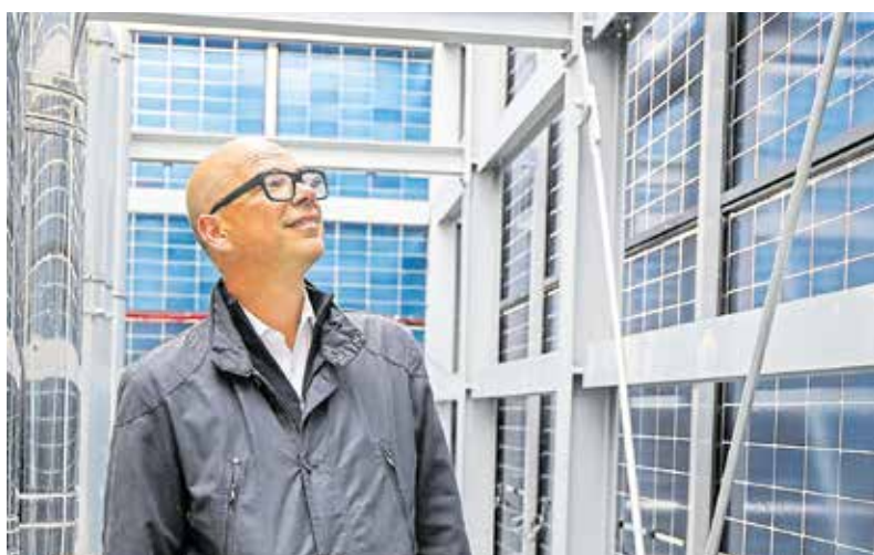
Im Innern der Energiezentrale ist hochmoderne Technik verbaut.
