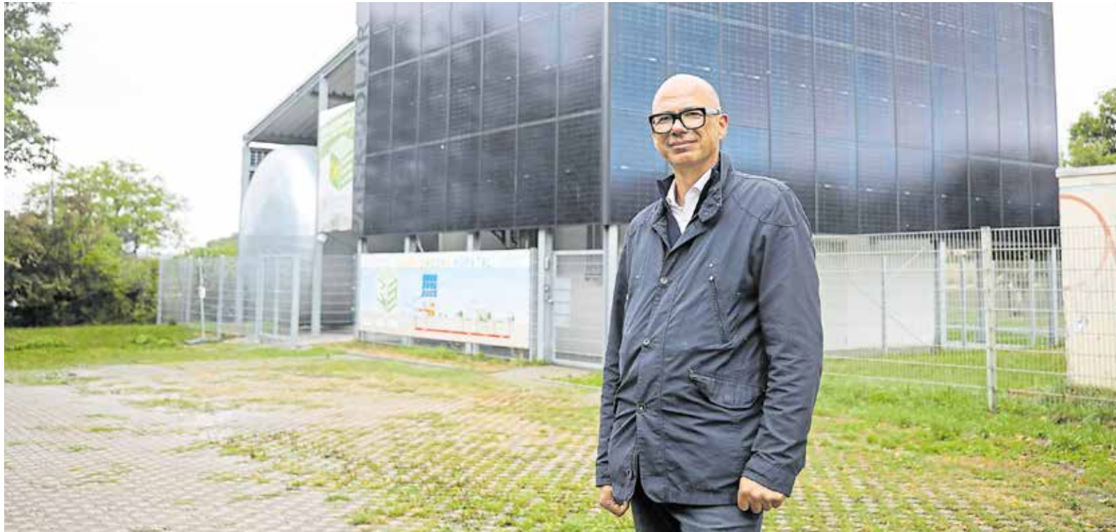
In nicht mal einem Jahr wurde die kubusförmige Energiezentrale in Korntal-Münchingen gebaut. Das Team von Jassen Mihaylov erstellte die blau-glänzende Photovoltaik-Fassade.
